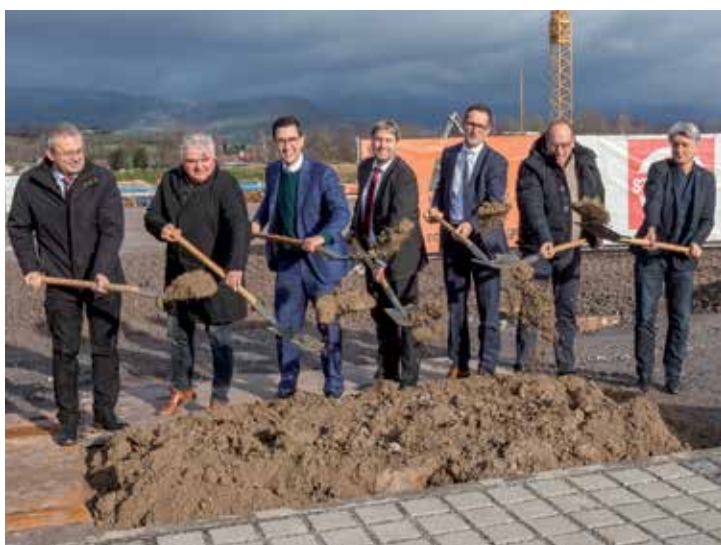
Landrat Josef Laumer, Bürgermeister Ludwig Waas, Christian Weigend (Bregal Unternehmerkapital), die Geschäftsführer Markus Karl und Alexander Rümmelein, Wirtschaftsreferent Erich Brunner sowie Architekt Christian Illner beim Spatenstich für die Produktionserweiterung im Herbst 2017
